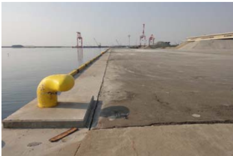
地盤改良実施部分
