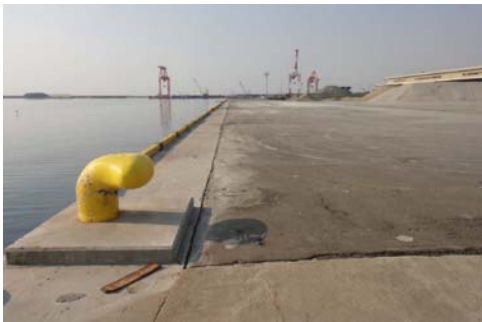
地盤改良実施部分
