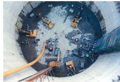
◀（左写真）土留工および土留掘削の底盤の被圧水対策としての大規模底盤注入 エキスバック工法
