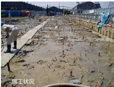
◀（左写真）土留工および土留掘削の底盤の被圧水対策としての大規模底盤注入 エキスバック工法
