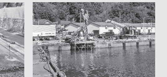
海中地盤の液状化対策
