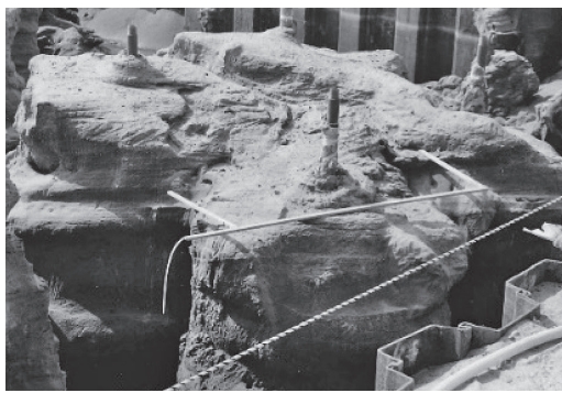
写真6 柱状浸透注入工法・エキスパッカ工法による低炭素グラウト[ハイブリッドシリカ]の高強度大径柱状連続固結体
