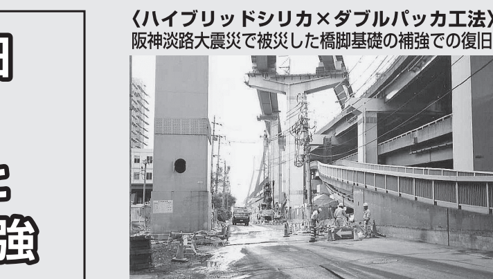
〈ハイブリッドシリカ×ダブルパッカ工法〉 阪神淡路大震災で被災した橋脚基礎の補強での復旧
