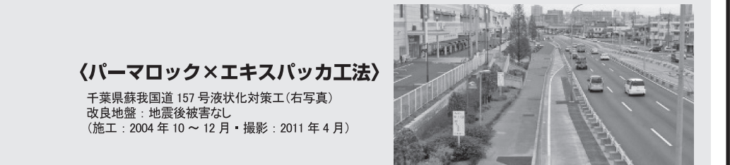
〈パーマロック×エキスパッカ工法〉 千葉県蘇我国道157号液状化対策工(右写真) 改良地盤: 地震後被害なし (施工: 2004年10~12月・撮影: 2011年4月)
