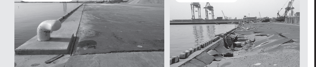
仙台塩釜港 改良地盤: 地震後被害なし (施工: 平成19年 撮影: 平成23年4月)
