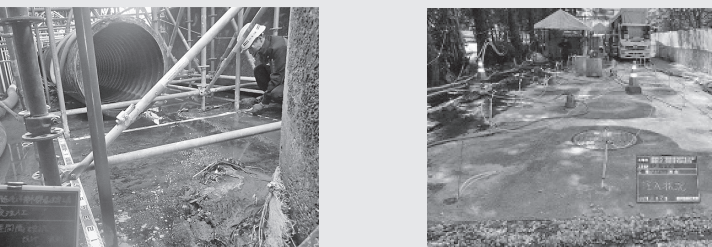
〈パーマロック×超多点注入工法〉 災害用貯水タンクの液状化対策
