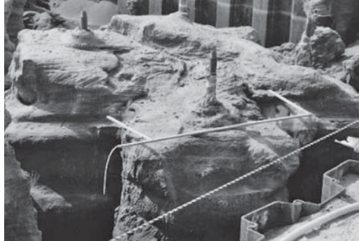
写真7 柱状浸透注入工法・エキスパック工法による低炭素グラウト「ハイブリッドシリカ」の高強度柱状連続固結柱
