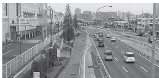
千葉県蘇我国道157号液状化対策工 改良地盤: (B)(C) 地震後被害なし (施工:2004年10～12月・撮影:2011年4月)
