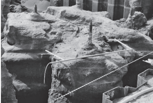
柱状浸透注入工法・エキスパッカ工法による低炭素グラウト「ハイブリッドシリカ」の高強度柱状連続固結体
