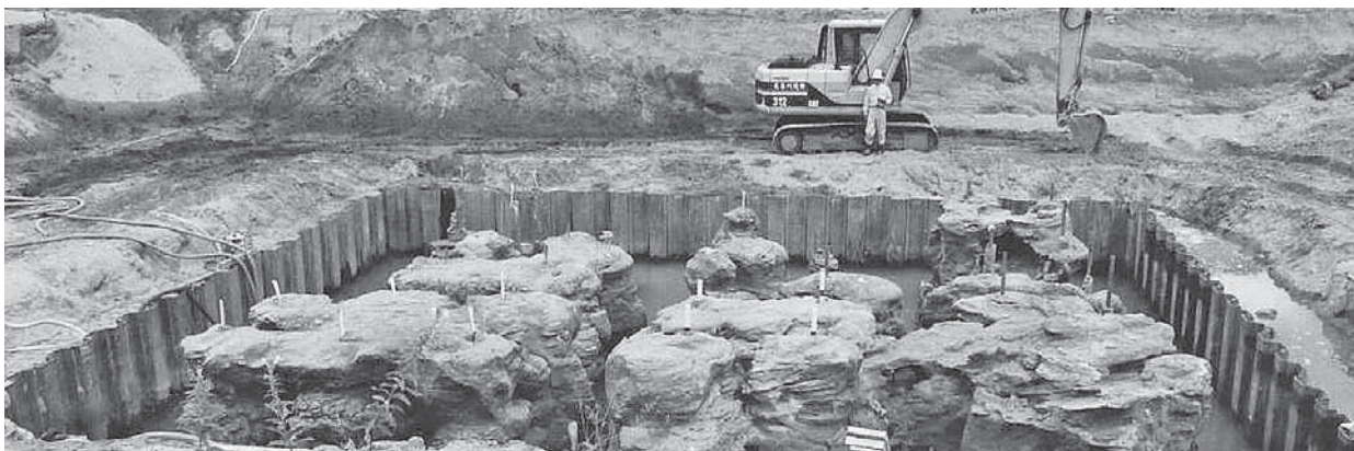
写真1 1999年産学協同研究による大規模野外試験(株)ADEKA鹿島工場敷地(神奈川県) 参考著書1)米倉・島田:薬液注入の長期耐久性と恒久グラウト本設注入工法の設計施工,近代科学社,2016.10 2)東畑・米倉・島田・社本:「地震と地盤の液状化-恒久・本設注入によるその対策」,インデックス出版,2010.10 3)恒久グラウト・本設注入協会:恒久グラウト注入工法 技術マニュアル,2017改訂版 4)「恒久グラウトと注入技術」平成14年度(公社)地盤工学会技術開発賞関連技術-付東北地方太平洋沖地震における施工地盤の追跡調査報告一,2014.10改訂版
