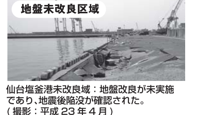
仙塩釜港未改良地盤: 地盤改良が未実施であり、地震後陥没が確認された。(撮影:平成23年4月)
