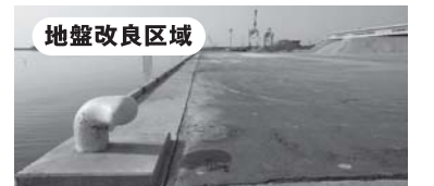
仙塩釜港改良地盤: (A)(C) 地震後被害なし (施工:平成19年・撮影:平成23年4月)
