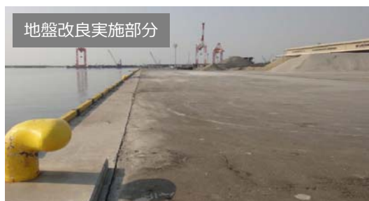
◀ 千葉県蘇我国道 157 号 液状化対策工 (A)(B)改良地盤： 地震後被害なし (施工：2004年10～12月・ 撮影：2011年4月)
