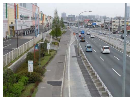
◀ 千葉県蘇我国道 157 号 液状化対策工 (A)(B)改良地盤： 地震後被害なし (施工：2004年10～12月・ 撮影：2011年4月)
